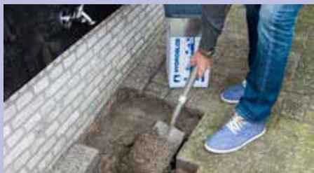
Benodigde diepte en breedte uitgraven
