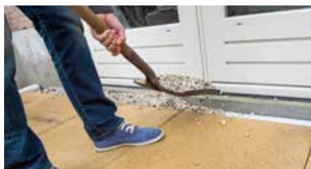
Of Hydroblob® blok zonder rooster plaatsen en afwerken met grind.
