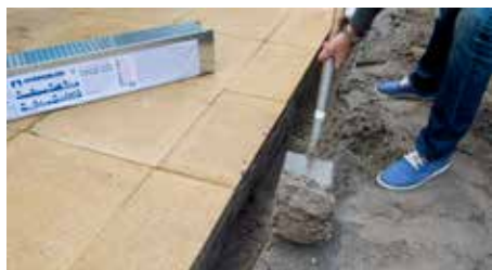
Benodigde diepte en breedte uitgraven
